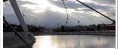
el puente de nunca acabar. Terminada hace meses tras una
