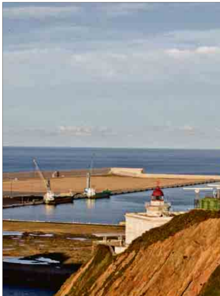
Vista del nuevo muelle Norte de la ampliación de El Musel. | ÁNGEL GONZÁLEZ
